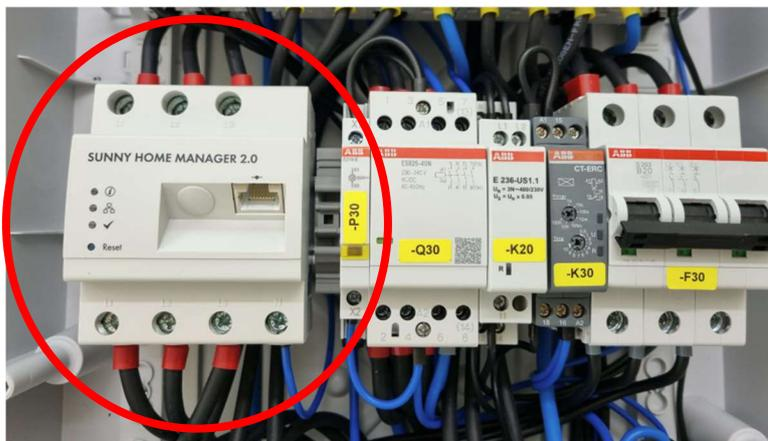
*Hinweis: Drehmoment für Schraubklemmen des Smart Meter = 2,0 Nm*
